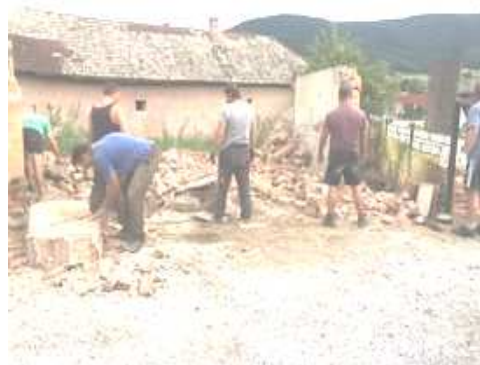
Zbúranie budovy starého skladu
